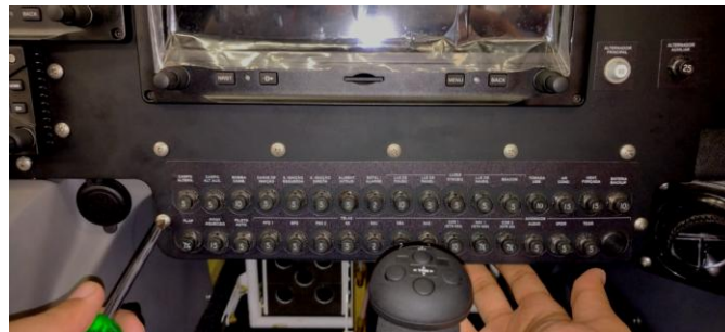
Figura 10 - Inserção da fixação da chapa de proteção dos disjuntores.
