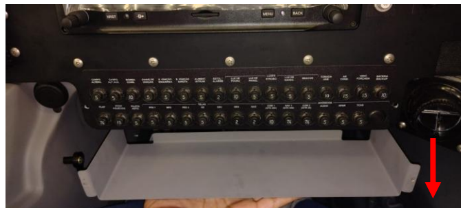
Figura 8 - Remoção da chapa de proteção dos disjuntores.
