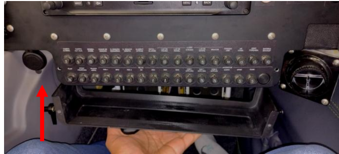
Figura 9 - Inserção da nova chapa de proteção dos disjuntores.
