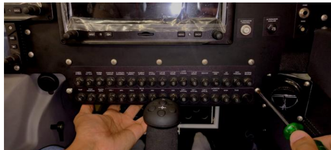
Figura 7 - Remoção da fixação da chapa de proteção dos disjuntores.
