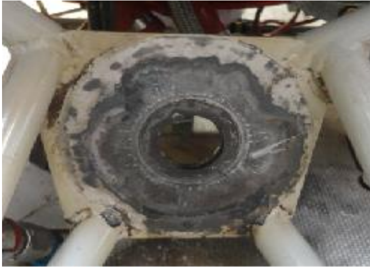
Exemplo de WD-1001E sem trincas
