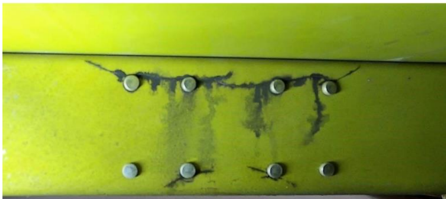
Figura 2 - Localização da trinca - Vista dianteira da longarina
